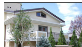
Villa unifamiliare Arese
